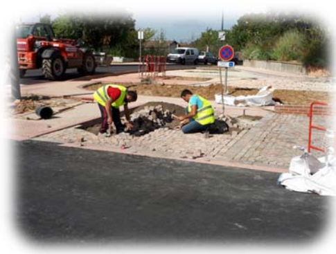
Place du Mail Pose des pavés de porphyre (en arceaux ou queues de paon).
