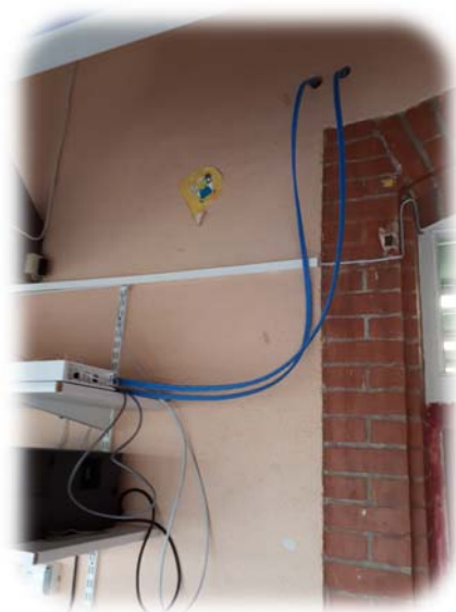
Rénovation du câblage informatique à l'école
