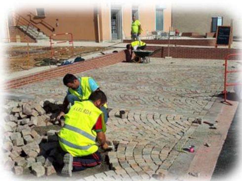
Place du Mail Pose des pavés de porphyre (en arceaux ou queues de paon).
