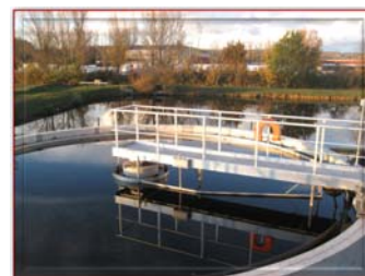
Bassin de décantation dans son cadre naturel
